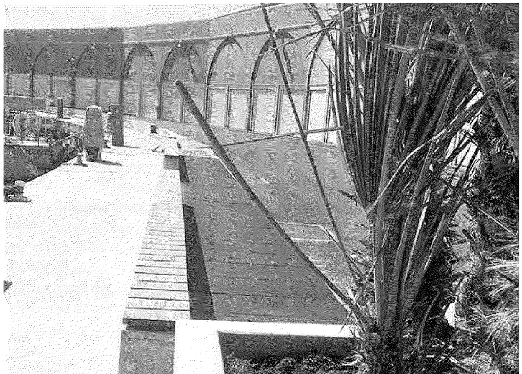
Una parte della nuova banchina realizzata al porto
