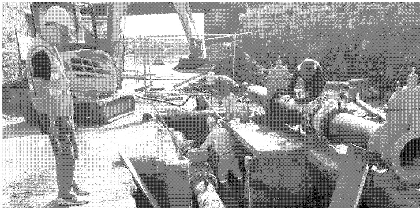
Lavori alla condotta idrica a Rio Marina
