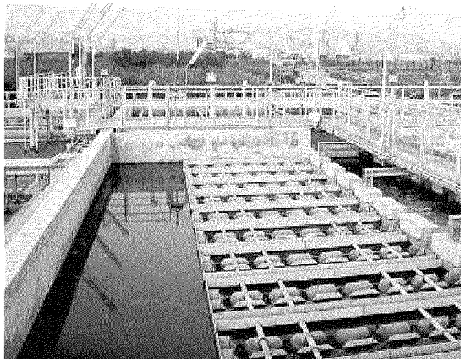
Il depuratore Aretusa per il recupero dell'acqua nel ciclo Solvay
