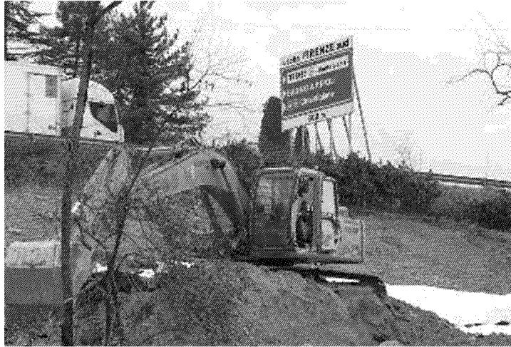
Lavori per la realizzazione della terza corsia dell'Autostrada del sole da Firenze sud fino a Incisa Valdarno
