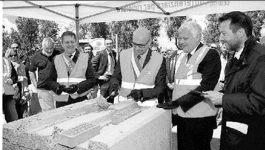
Il ministro Galletti e i sindaci alla posa della prima pietra per la costruzione dell'impianto
