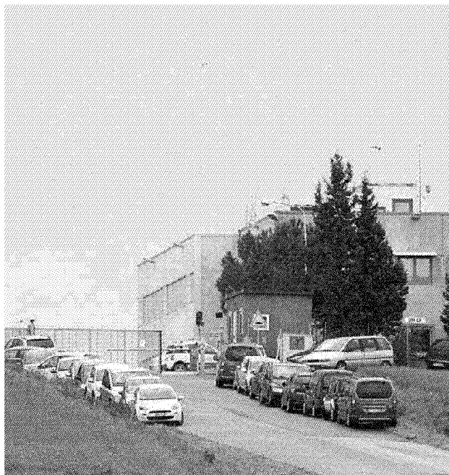
Una veduta dell'ingresso di Scapiigliato e in alto il sindaco Franchi
