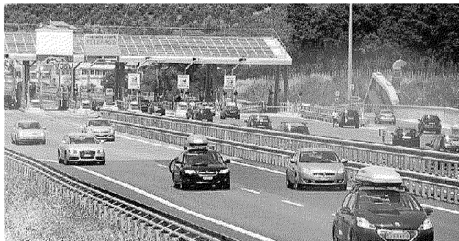
Un tratto della Tirrenica già realizzata
