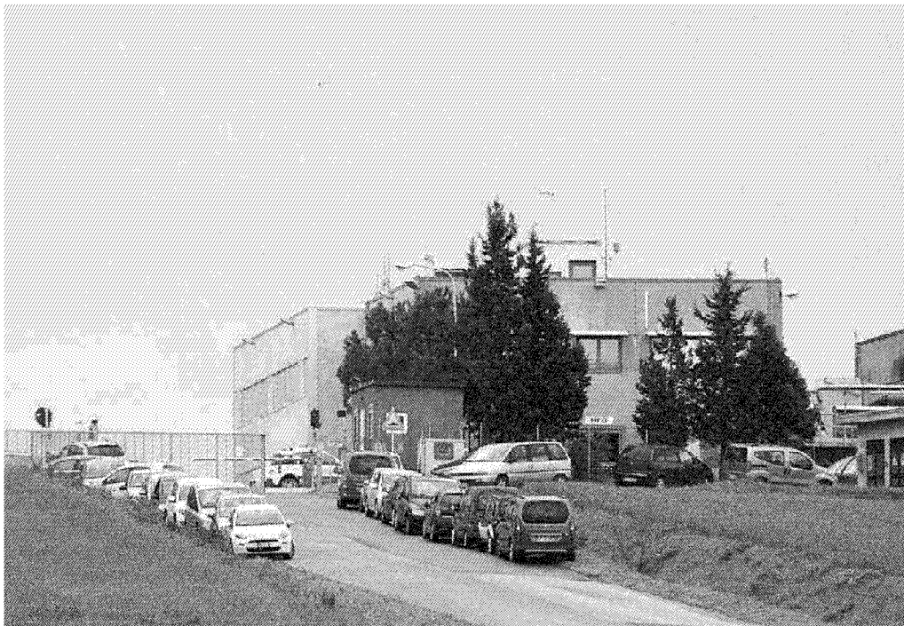
L'ingresso della discarica di Scapigliato
