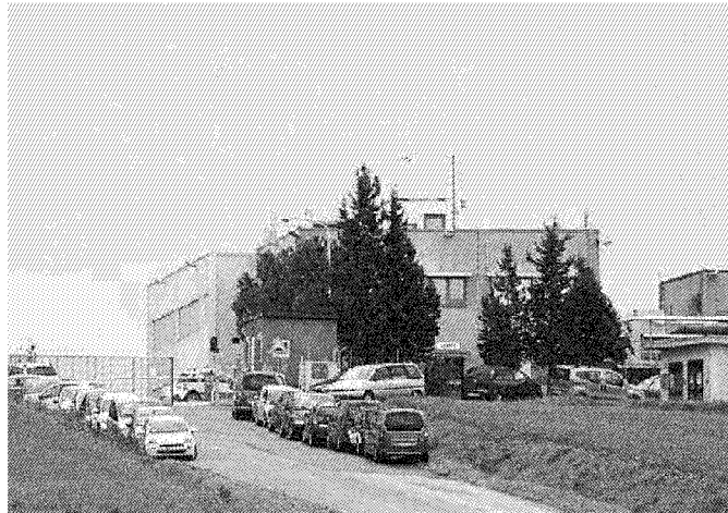
L'ingresso della discarica di Scapigliato
