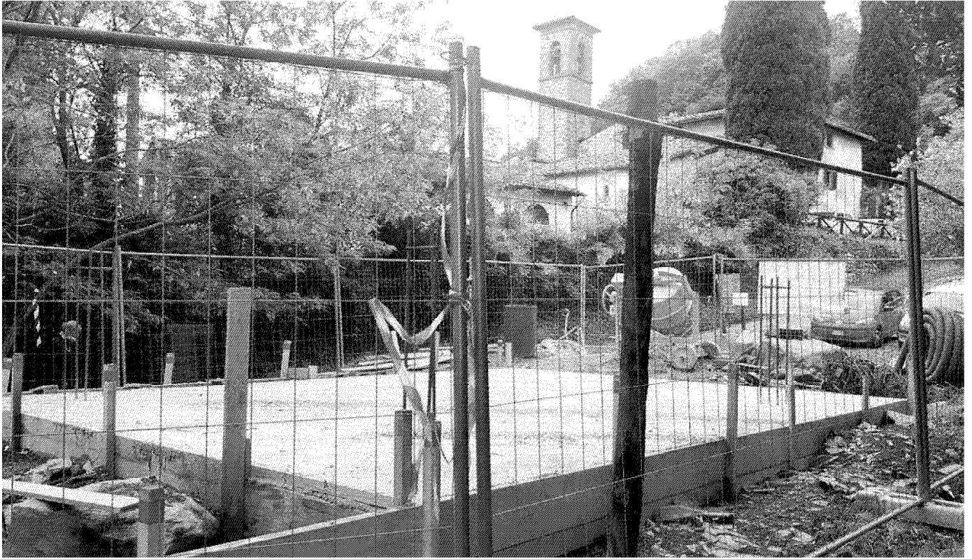
La piattaforma di cemento davanti alla scuola di Barbiana su cui appoggeranno i bagni e, sotto, i lavori per le tubature di scarico
