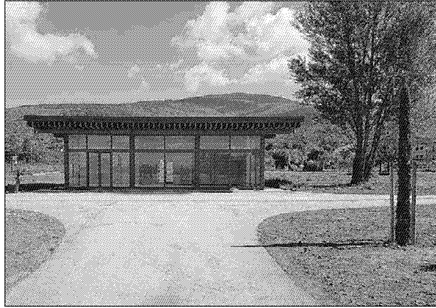
Parco archeologico Lavori in dirittura con la costruzione, tra le altre cose, anche di un centro accoglienza per turisti nella zona di Cortona
