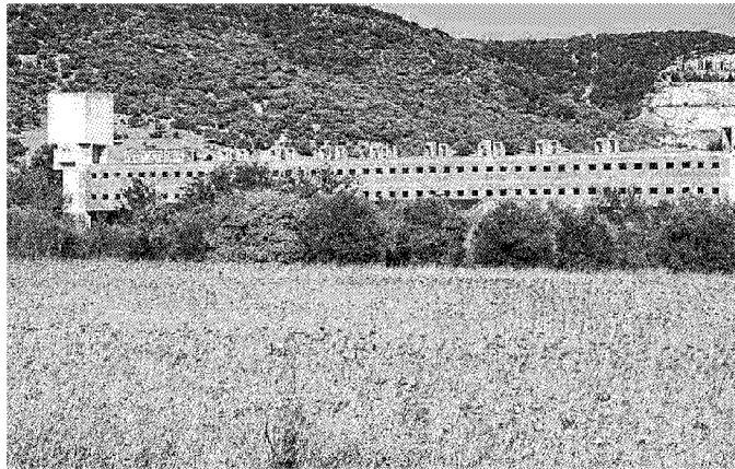
Il rudere delle Terme di Roselle che sarà demolito entro fine anno (foto Bf)
