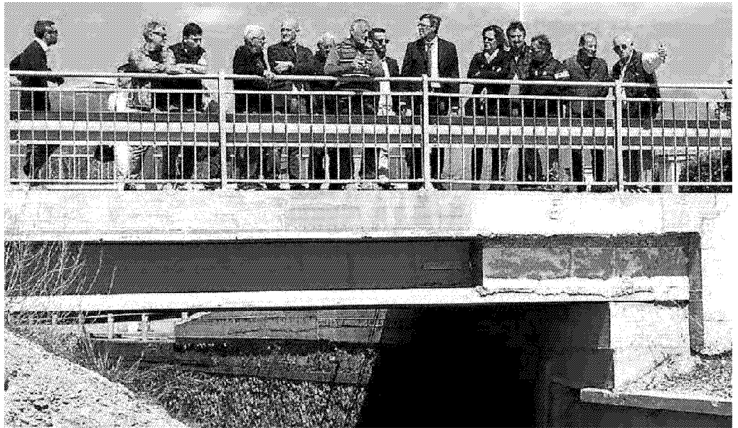
Il sopralluogo sui luoghi dell'alluvione
