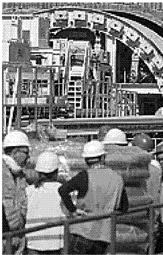
Il cantiere del tunnel Tav
