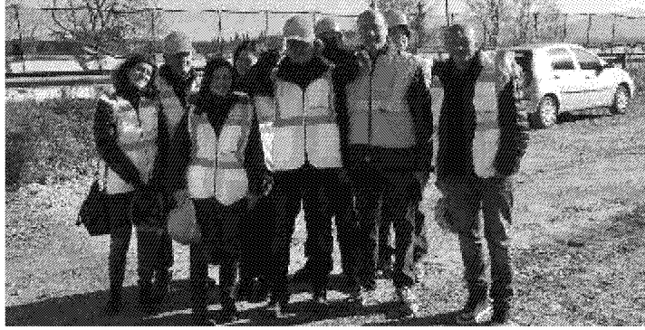
Sopralluogo tecnico sul cantiere della terza corsia dell'autostrada del Sole
