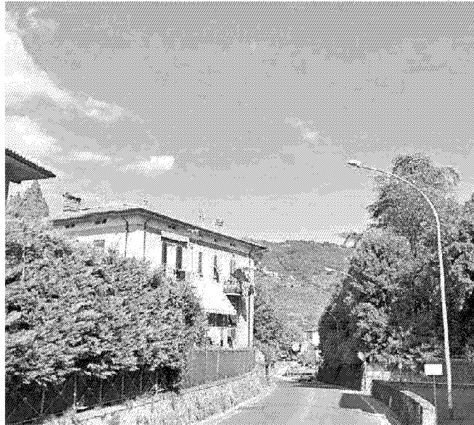
Un tratto della via Lucchese che attraversa l'abitato di Pescia
