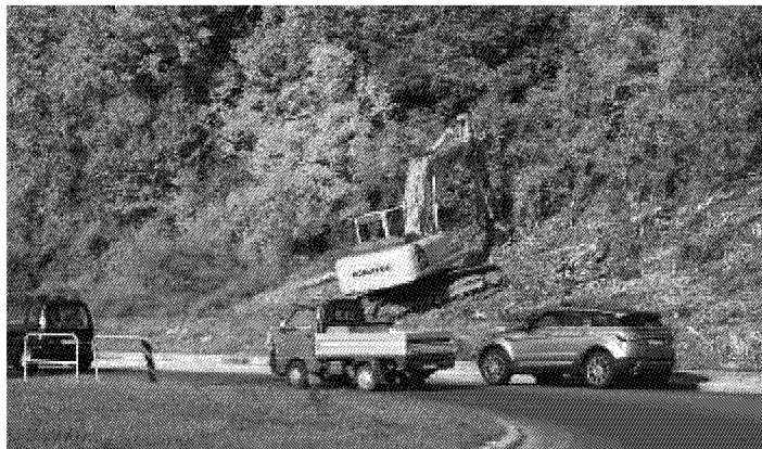
Lavori alla rotatoria di Ponte a Niccheri in vista della variante
