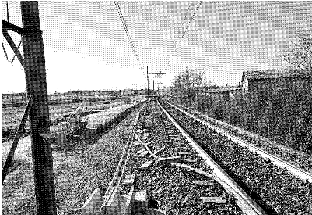
In alcuni tratti del cantiere si procede già alla posa del binario (Foto Nucci)
