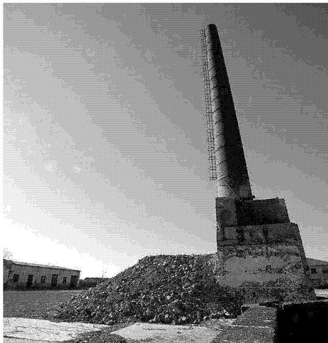
L'area delle ex Officine Minnetti spianata per il cantiere (Foto Nucci)
