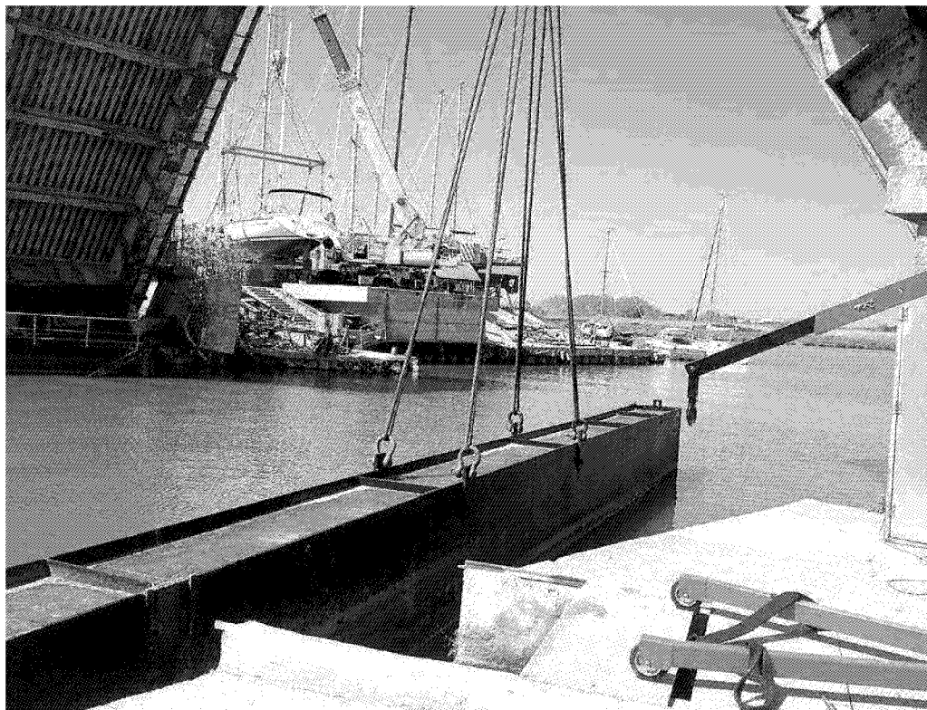
Le porte vinciane tra lo Scolmatore e il porto: da qui passano gli yacht pisani e la sabbia che abbassa i fondali in porto
