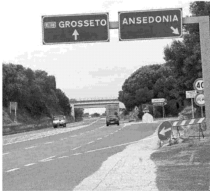
Un tratto dell'Aurelia che dovrà lasciare il posto all'autostrada
