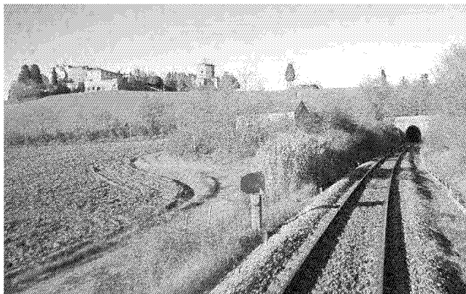
Un tratto della ferrovia che passa da Monte Antico
