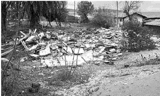
Le macerie lasciate dalle ruspe appena dopo le ultime demolizioni
