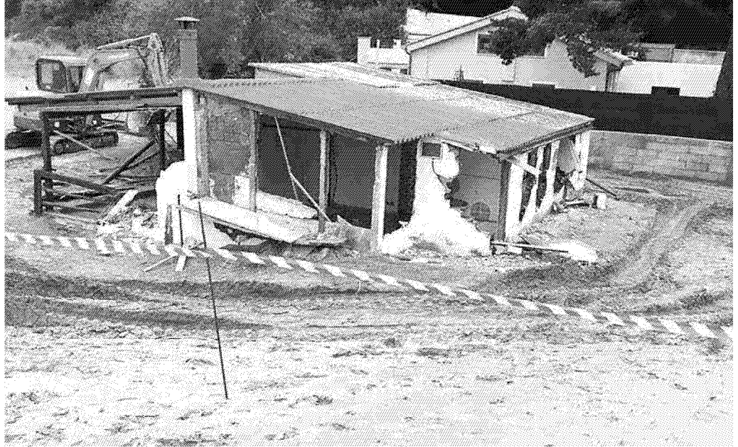
Le ultime immagini delle casette in Feniglia, poco prima della demolizione
