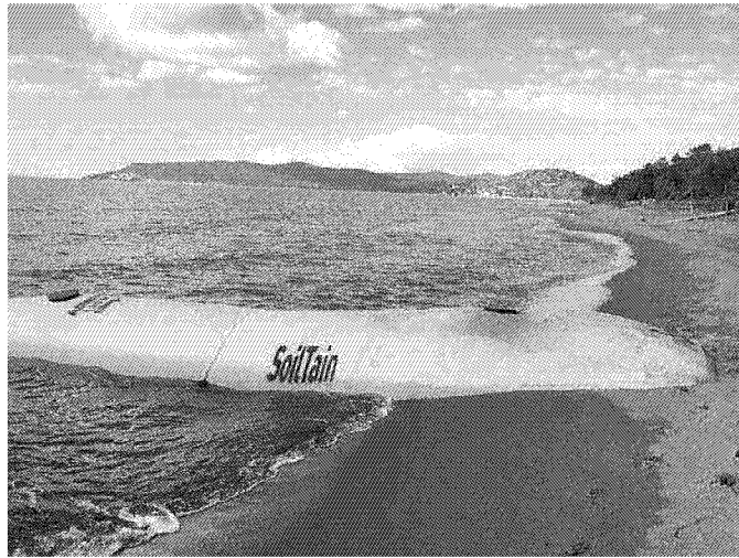
Uno dei geotubi che sono stati posizionati dal campeggio Oasi all'Hawai
