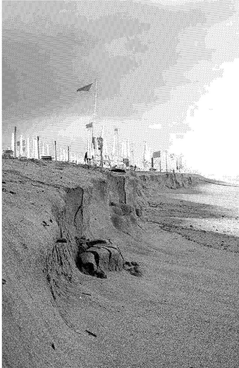
Lo scalino: uno degli effetti dell'erosione
