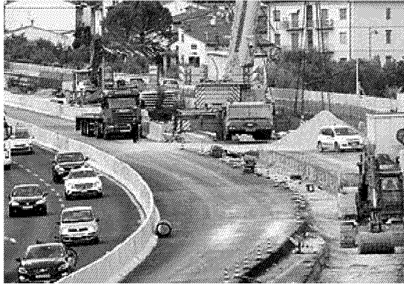
Lavori per la realizzazione della terza corsia sull'autostrada A-1
