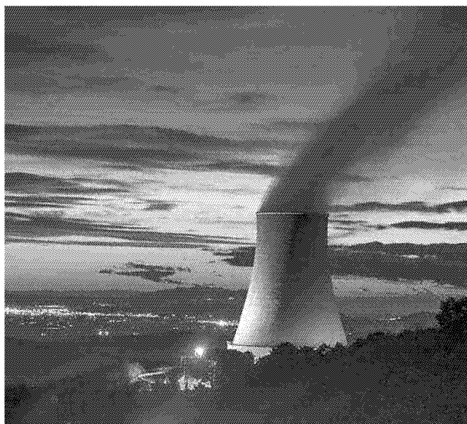
Un impianto geotermico a Larderello (Foto di repertorio)
