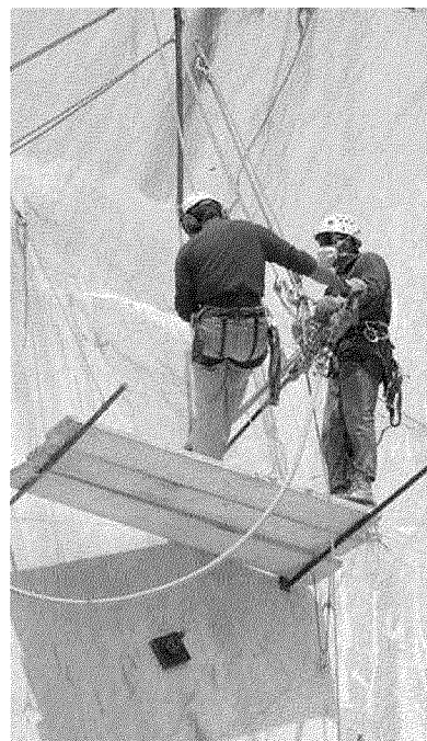
Cavaletti al lavoro (foto d'archivio)
