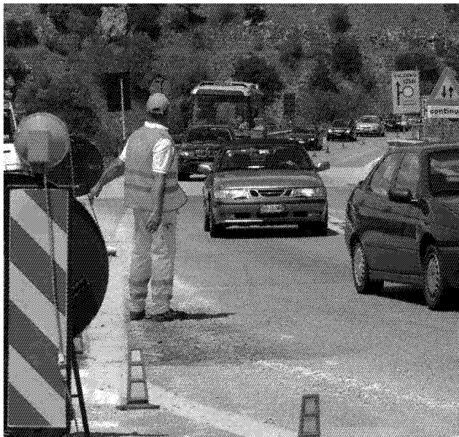
Cantieri sulla A3 Salerno-Reggio Calabria (foto di repertorio)
