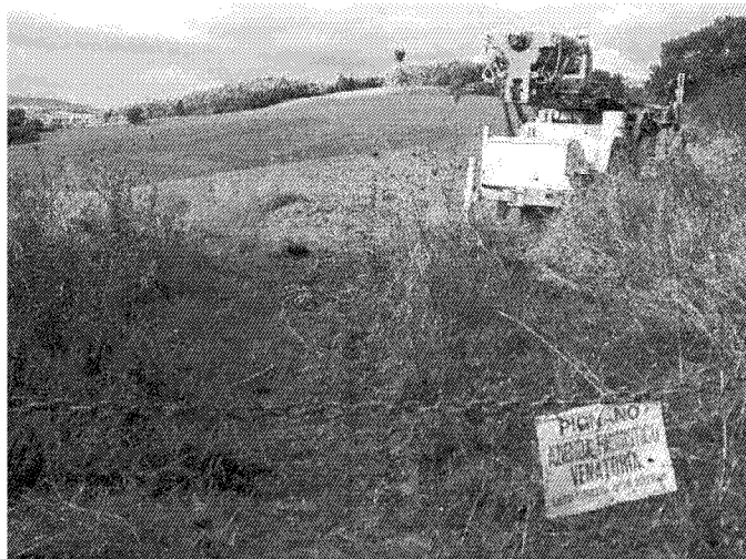
Il macchinario per la ricerca geotermica a Pignano
