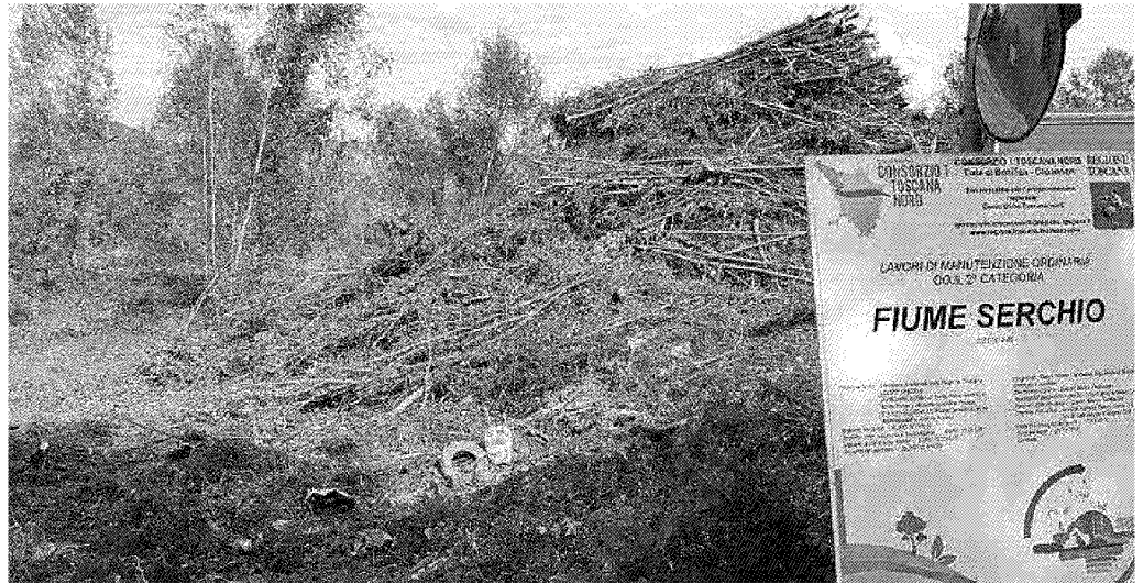
Vegetazione rimossa dal fiume e dalle sponde
