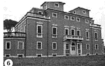
6 Massa Villa la Rinchiostra
