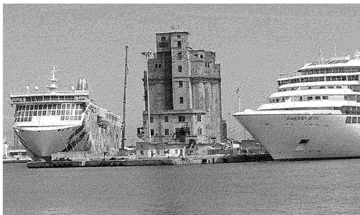
Il porto passeggeri: a sinistra un traghetto Moby, a destra la love boat Seabourn Quest e in mezzo l'ex silos
