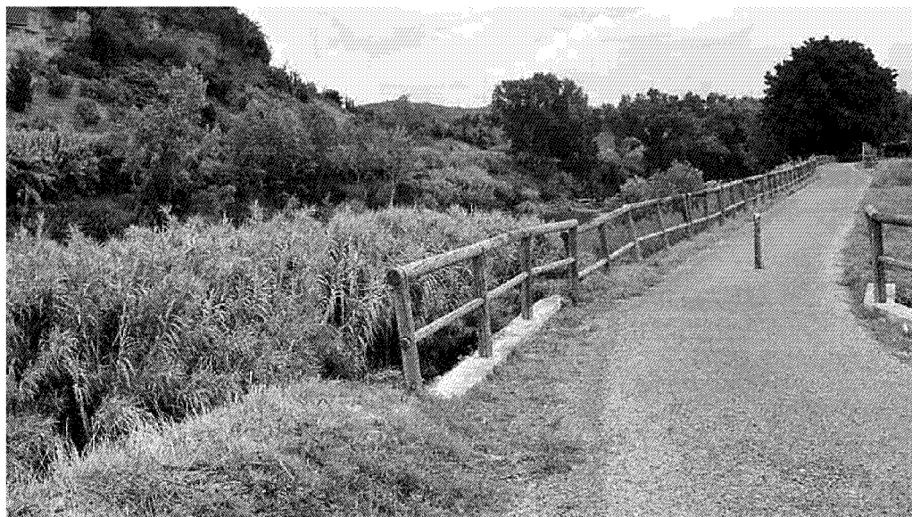
Un tratto della ciclopista dell'Arno nella zona di Montelupo (Foto Sestini)
