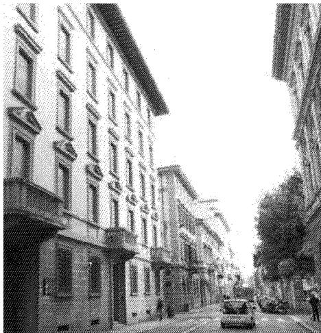
Il palazzo conteso in via Cavour
