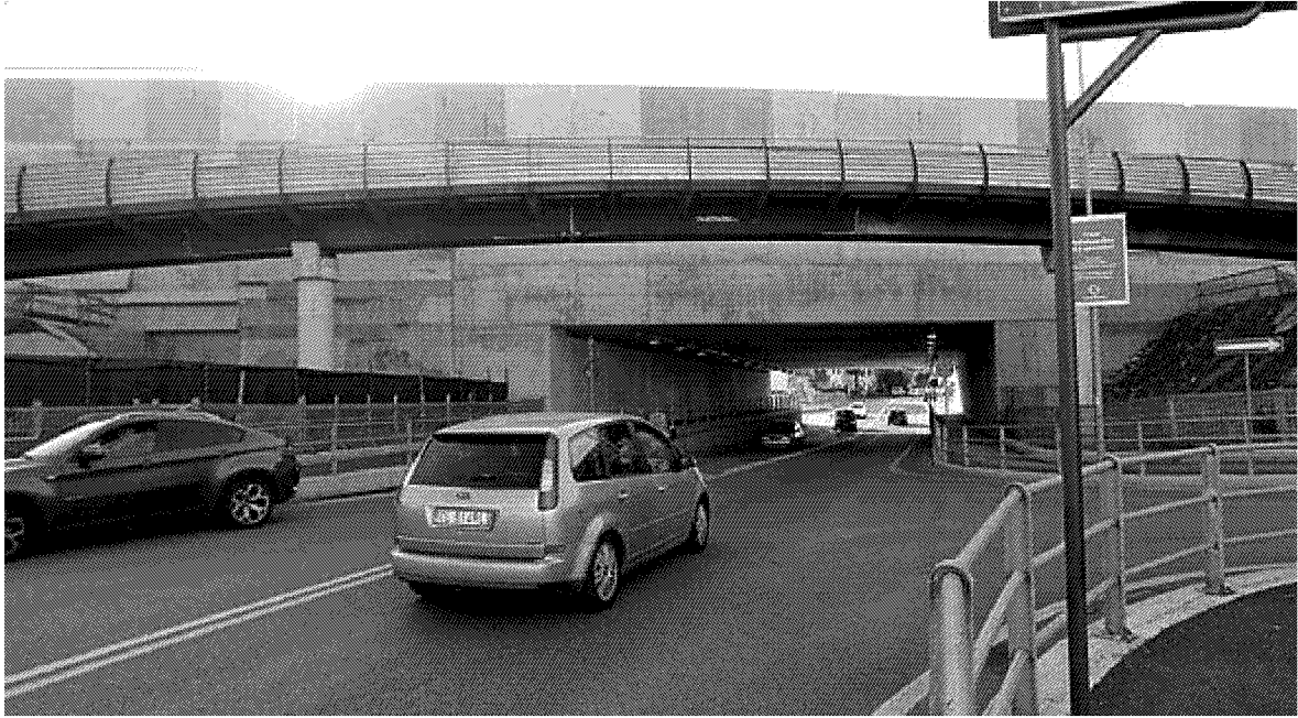
Galleria artificiale di Casellina lungo l'autostrada A1 (Foto Germogli)
