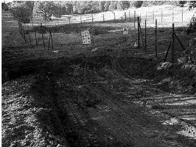
I lavori di scavo del pozzo di ricerca di fluido geotermico a Pancole
