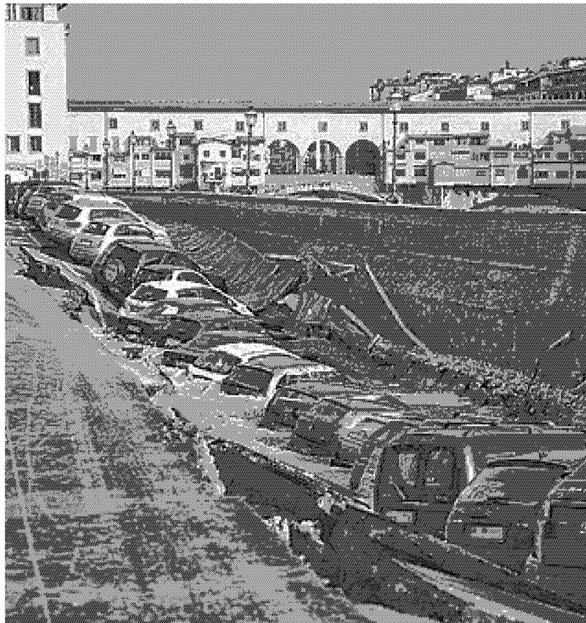
Il crollo del lungarno Torrigiani è avvenuto lo scorso 25 maggio dopo la rottura di una grossa tubatura
