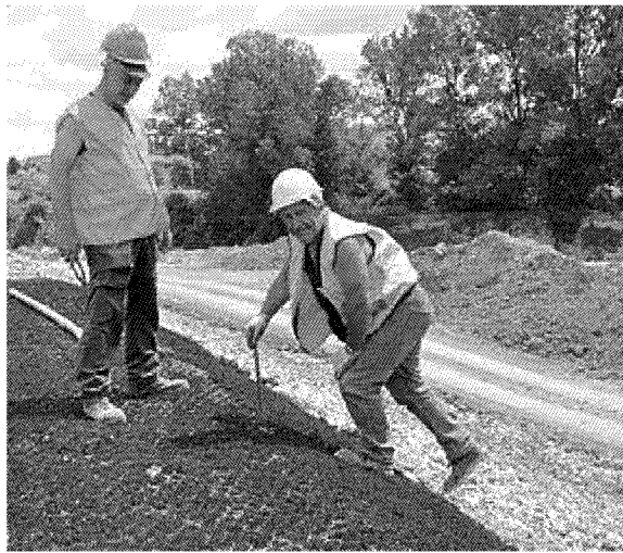
IMPEGNO Alcuni lavori già effettuati sugli argini del fiume Ombrone
