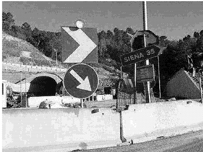
Pari, lavori lungo la Senese (foto d'archivio)
