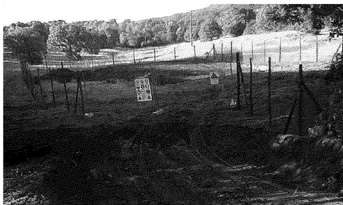
La zona dei lavori per scavare il pozzo, nel comune di Scansano
