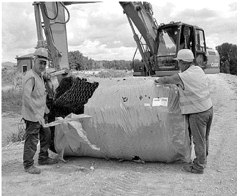
AL LAVORO Operai impegnati nel consolidamento degli argini. Per il Serchio e Bocca d'Arno in arrivo oltre 13 milioni di euro
