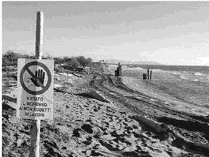
L'intervento di ripascimento vicino alla foce dell'Ombrone
