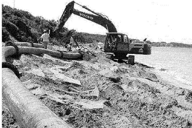
Lavori sulla spiaggia del Voltoncino ad Albinia (foto Russo)
