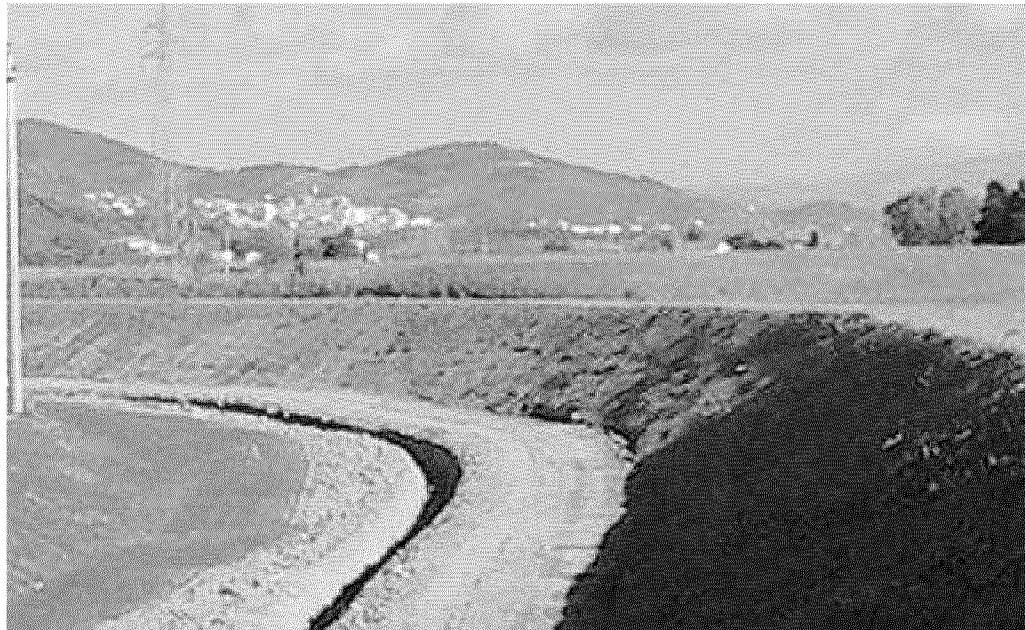
Lavori agli argine del fiume Cornia
