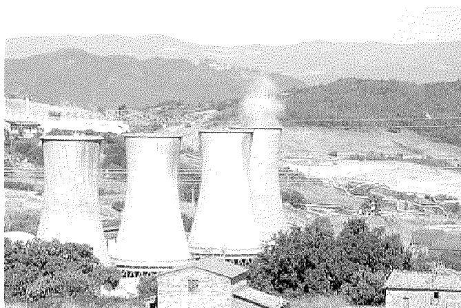
Un impianto geotermico in Valdicecina
