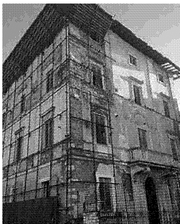
L'edificio dell'ex hotel Nettuno
