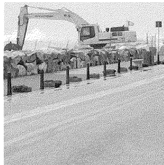
Lavori fermi alle spiagge di Marina di Pisa
