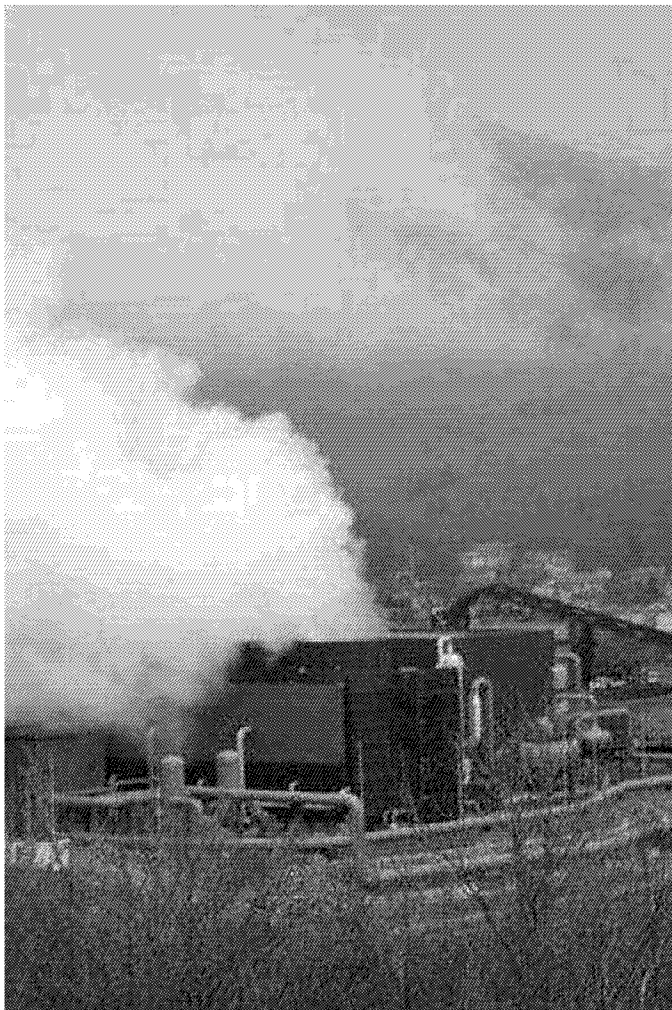
La centrale geotermica di Bagnore a Santa Fiora
