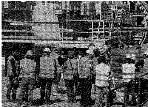
LAVORI FUORI CORSO Scatti sui cantieri del nodo fiorentino dell'alta velocità, bloccati da due anni
