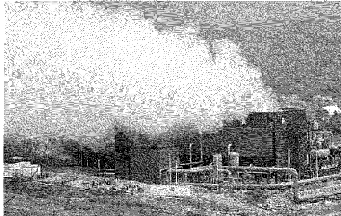
La centrale geotermica Bagnore 4 di Enel green power
