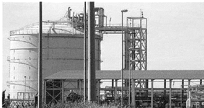
Il deposito dell'etilene Solvay
